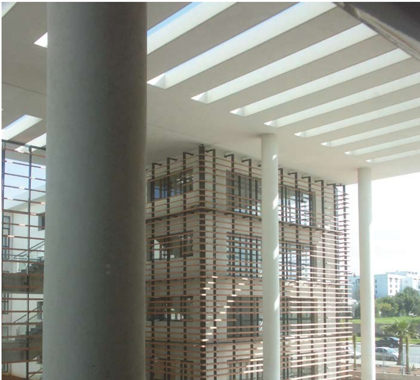
Le brise-soleil en terre cuite sert de double peau pour filtrer la lumière tout en créant des lames d'air ventilées
