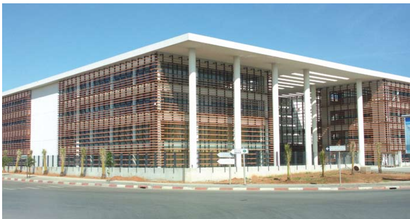
Vue d'ensemble du nouveau siège montrant le pare-soleil en terre cuite
